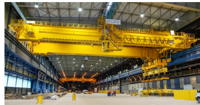
더블 거더 크레인
